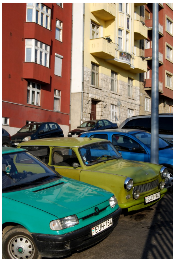
Les niveaux de logements en mauvais état atteignent 10% en Hongrie – mais à Budapest, des investissements ont rendu la rénovation des bâtiments possible.
