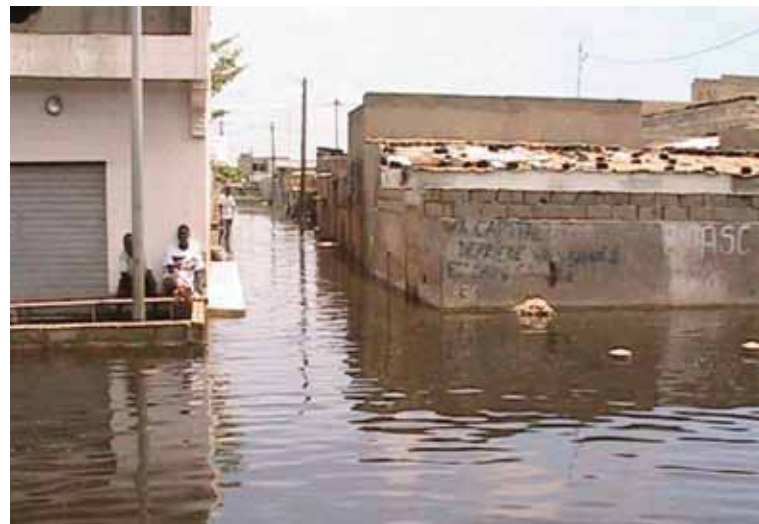
Photo 4. Habitations Nassourilahi sous les eaux
